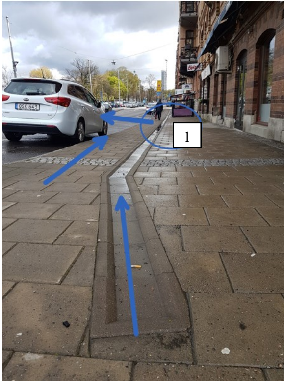
Figur 19. Bild tagen vid ett platsbesök 2020-04-28 för att illustrera hur avrinningen (blå pilar) leds mot lågpunkt 1 intill de gamla fastigheterna (blå cirkel) där skyfallsstråk 2 korsar Engelbrektsgatan. Vatten ansamlas vid den blå cirkeln tills det bräddar över Engelbrektsgatan norrut mot Heden (pilen riktad vänster i bilden). Bilden är tagen längs med Engelbrektsgatan i riktning mot Skånegatan.
