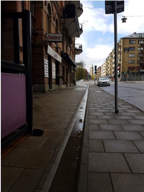
Figur 8. Bild tagen vid ett platsbesök 2020-04-28 som visar att golv och portnivåer ligger i samma höjd som vägen för de äldre fastigheterna längs den södra sidan av Engelbrektsgatan mellan Södra Vägen och Wadmansgatan. Bilden är tagen från lågpunkt 1 i riktning mot Södra Vägen.
