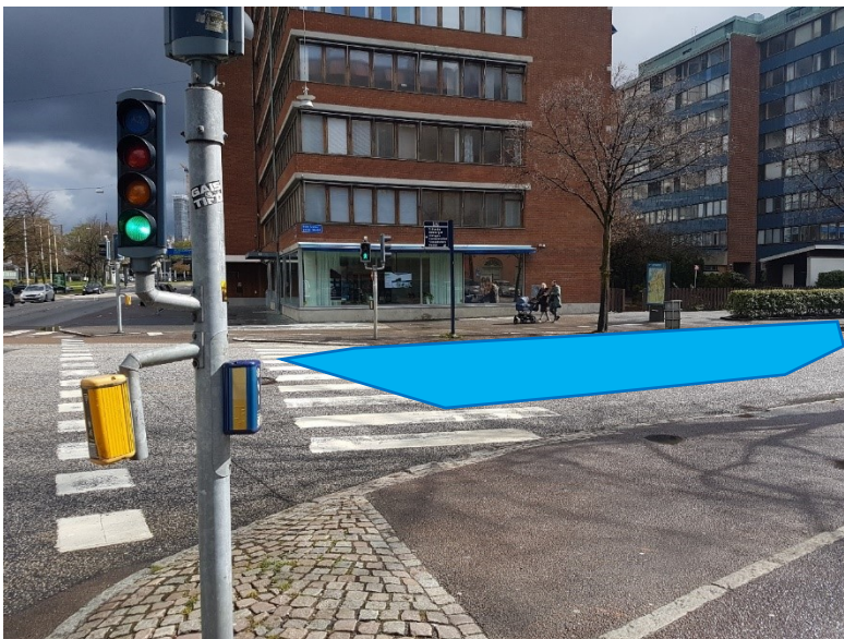
Figur 9. Bild tagen vid ett platsbesök 2020-04-28. Ungefärlig lokalisering av lågpunkt 2 i blått. Golvnivån är något upphöjd för fastigheten intill lågpunkt 2 i korsningen mellan Engelbrektsgatan och Sten Sturegatan. Bilden är tagen från Engelbrektsgatan i riktning mot Skånegatan med Sten Sturegatan till höger i bilden. I bilden ses också hur vägen är sänkt längs Sten Sturegatan vid övergångstället innan korsningen.
